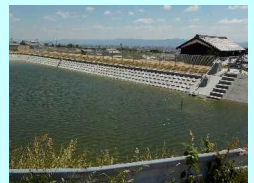
ため池の改修
