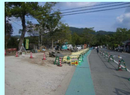
【三輪山線】工事状況
