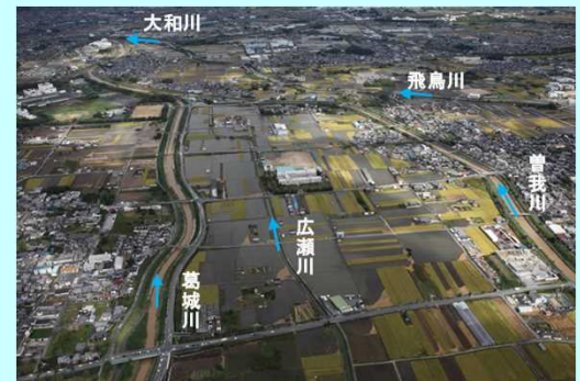
平成29年台風第21号の際の内水被害状況(広陵町大場地区付近)
