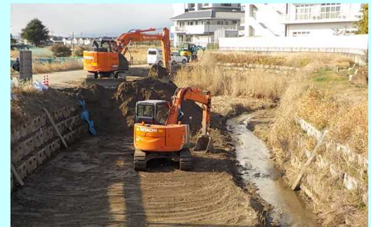
河道掘削状況(布留川北流)
