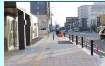
【奈良橿原線】工事状況
