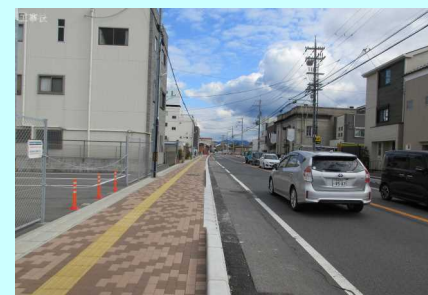
【畝傍駅前通り線】工事状況
